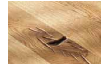
Offene Äste/Risse ausgeschliffen
